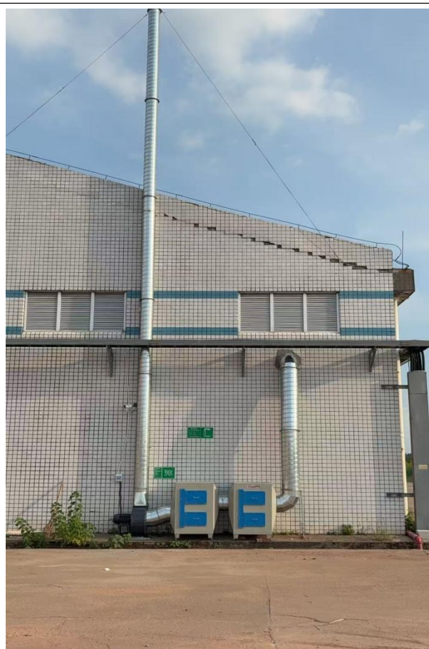
15m 高排气筒
