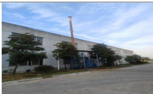
DA003 废气排放口
