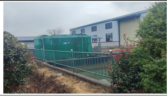
雨水池和应急事故池
