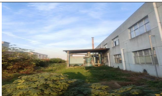
DA002 废气排放口
